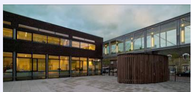
Zicht van op de speelplaats: verbodingsbrug en nieuwbouw. Foto: Arthur Bagen.
