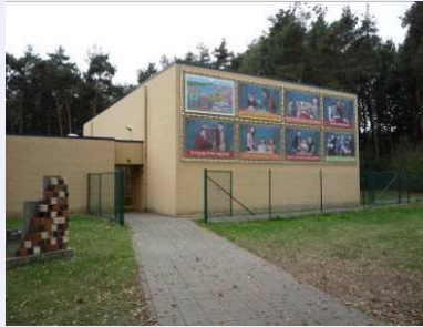
Sporthal en aparte ontsluiting via hekkenwerk. Foto: AGION.
