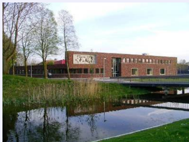
Vensterhuis Lewenborg: centrale voorziening voor brede school activiteiten in de wijk. Bron: WAL architecten.
