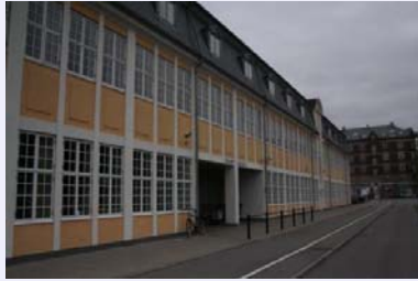
Verbouwde porseleinfabriek voor onderwijs en buitenschoolse opvang. Bron: AGION
